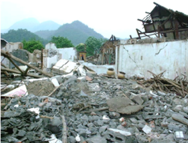
图 12 受灾的木结构、砖结构住宅 2008 绵竹、四川
