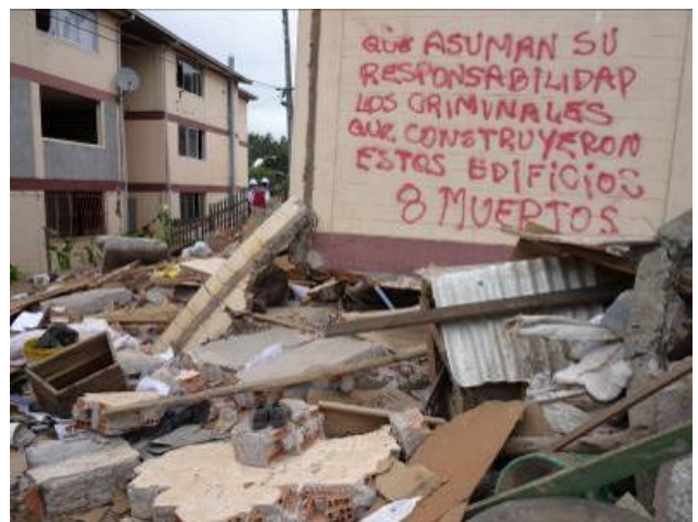
图25 2009年智利地震中受损的建筑(1层楼层坍塌)
