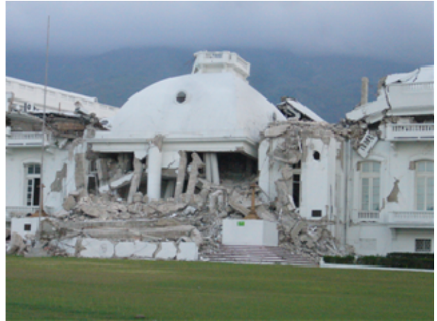
图 16 垮塌的总统府 2010 海地（CODE 提供）
