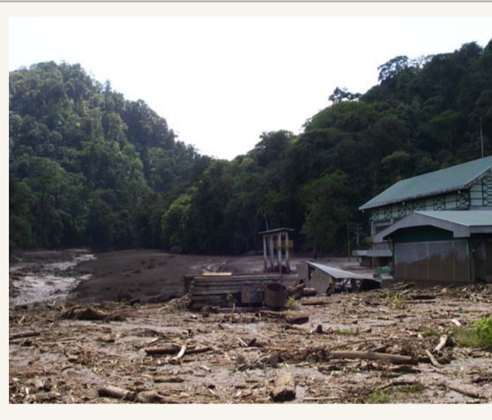
Flujo de lodo en río Sarapiquí, aludado a Casa de Máquinas de la Planta Hidroeléctrica Cariblanco, ubicada en Cariblanco, Sarapiquí de Alajuela.
