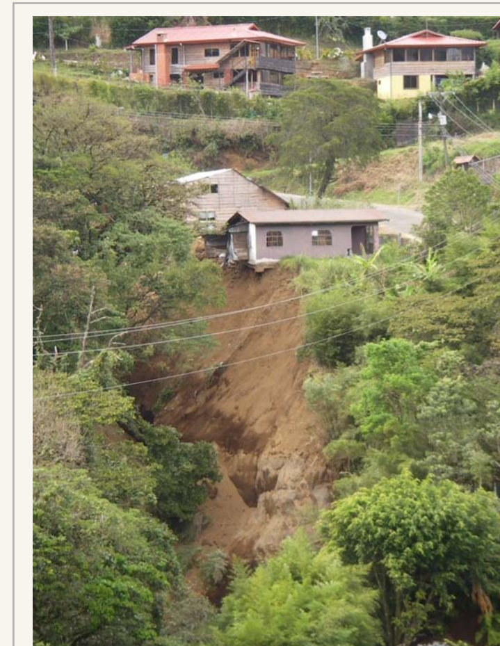
Casa en peligro de colapso en Fraijanes, Sabanilla de Alajuela, debido a deslizamiento aludado en materiales de cenizas volcánicas.
