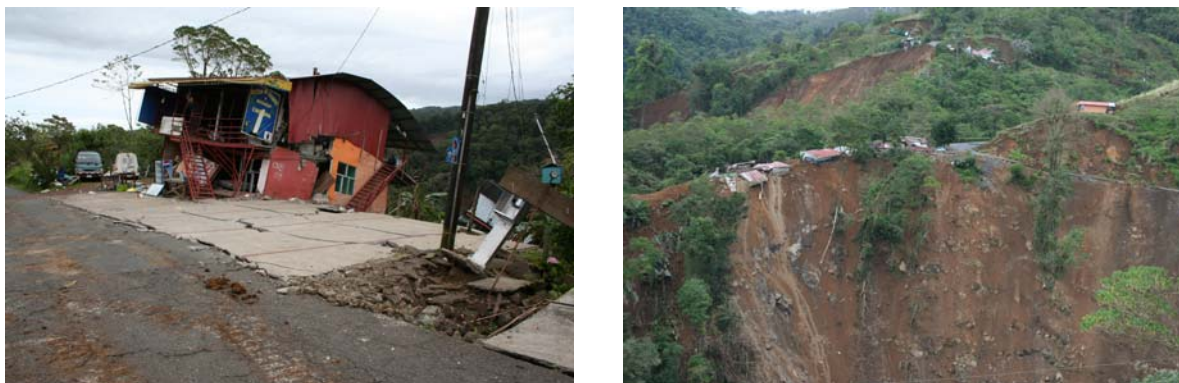
Fig. 5.5 Daños a viviendas y comercios por ubicación en lugares inapropiados.
