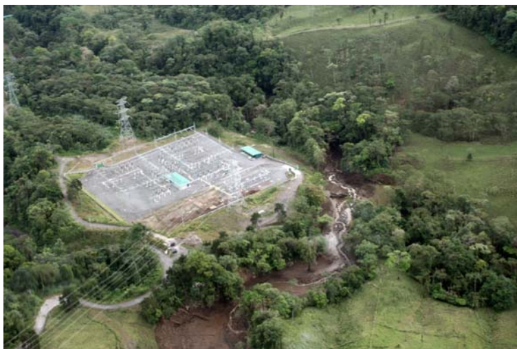
Fig. 5.11 Subestación eléctrica amenazada por el paso de una avalancha.
