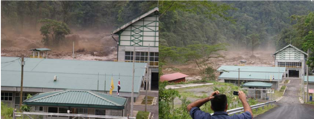
Fig. 4.2. La corriente de lodo transitando por el río Sarapiquí y las instalaciones en las instalaciones de Casa de Maquinas. Se observan los grandes bloques de ignimbritas de casi 10 m de diámetro transportados como por rodamiento. De igual manera se observa el spray barroso de casi 60 m de altura durante el transporte del flujo (Fotografía de G. Hernández, 13: 45 h del 8 de enero, 2009).
