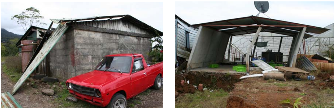
Fig. 5.9 Respuesta satisfactoria, pero aún mejorable, de estructuras a base de materiales prefabricados.
