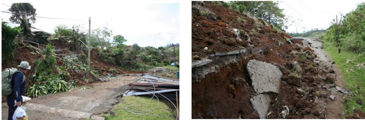
Fig. 5.4 Deslizamiento de taludes de poca altura compuestos por suelos volcánicos sueltos.
