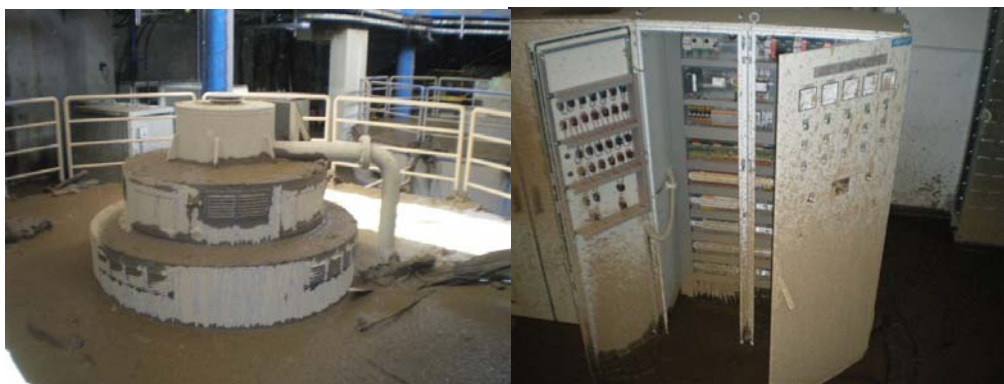
Fig. 4.18: Efectos despreciables de los flujos de barro sobre la infraestructura pero considerable en los equipos electromecánicos de la Casa de Máquinas de Cariblanco y edificios aledaños (Fotografías G.J. Soto, arriba; y archivos ICE, abajo).
