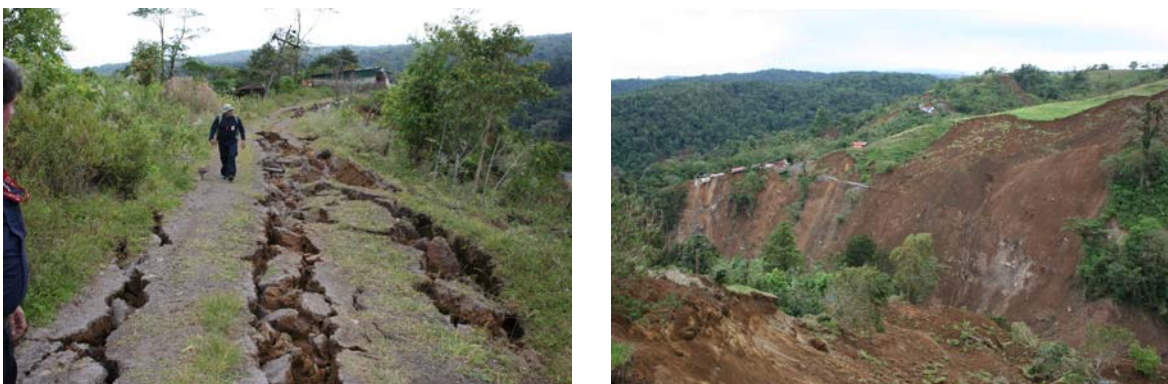
Fig. 5.10: Infraestructura vial dañada por la ausencia de un diseño apropiado
