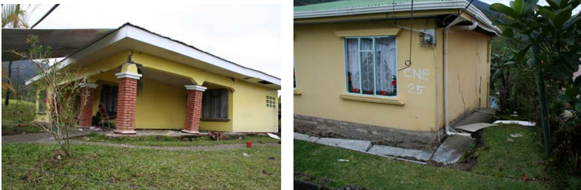
Fig. 5.8 Ejemplos de viviendas con comportamiento aceptable ante la sacudida sísmica.
