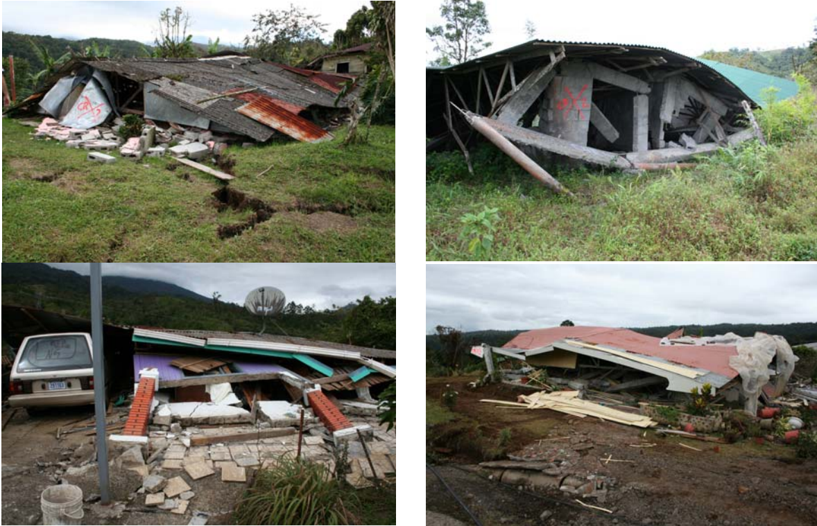
Fig. 5.7 Ejemplos de viviendas colapsadas, carentes de diseño sismo-resistente.
