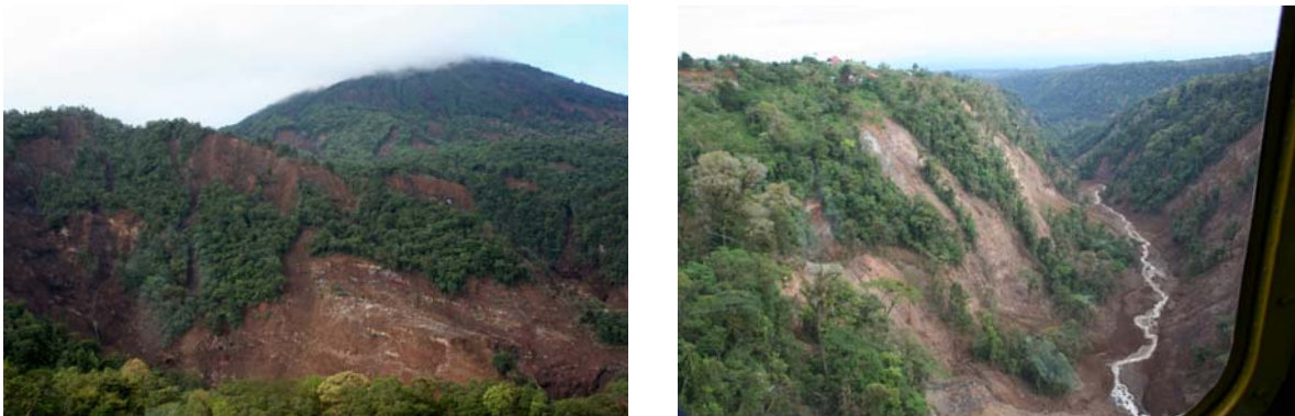
Fig. 5.2 Deslizamientos concentrados en el tercio superior de las laderas y deposición de materiales en ríos y quebradas.
