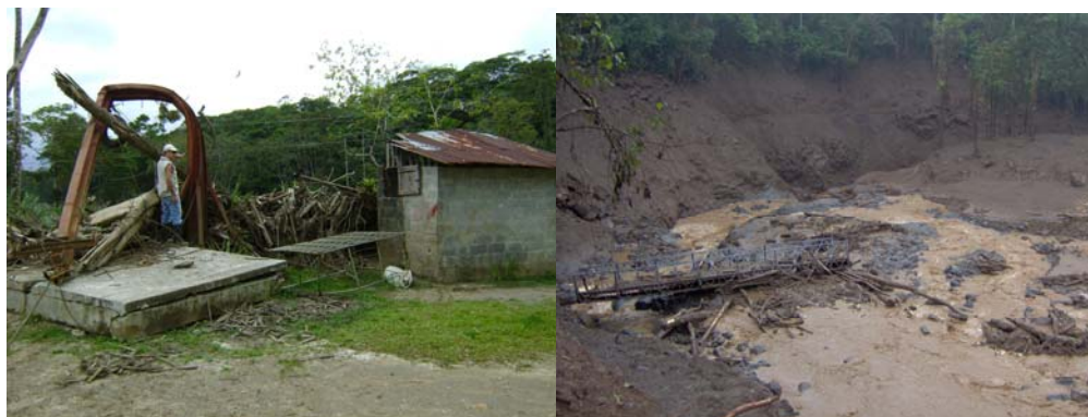
Fig. 4.20: A la izquierda se pueden observar los efectos dejados por el flujo del 8 de enero el caseta del moto de un andarivel y las retorceduras de los postes de acero. La casetilla sobrevivió pero debe de ser demolida. A la derecha, el Puente "Bailey" arrasado unos 75 m por el flujo del río Ángel del 21 de enero de 2009 (Fotografía G.E. Alvarado, 22 de enero, 2009).
