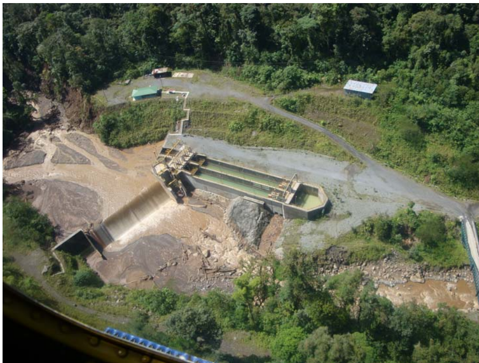
Fig. 4.19: Efectos relativamente menores de los flujos de barro sobre la presa del Sarapiquí (Fotografía E. Campos).
