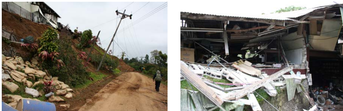
Fig. 5.6 Afectación en plantas de producción de alimentos
