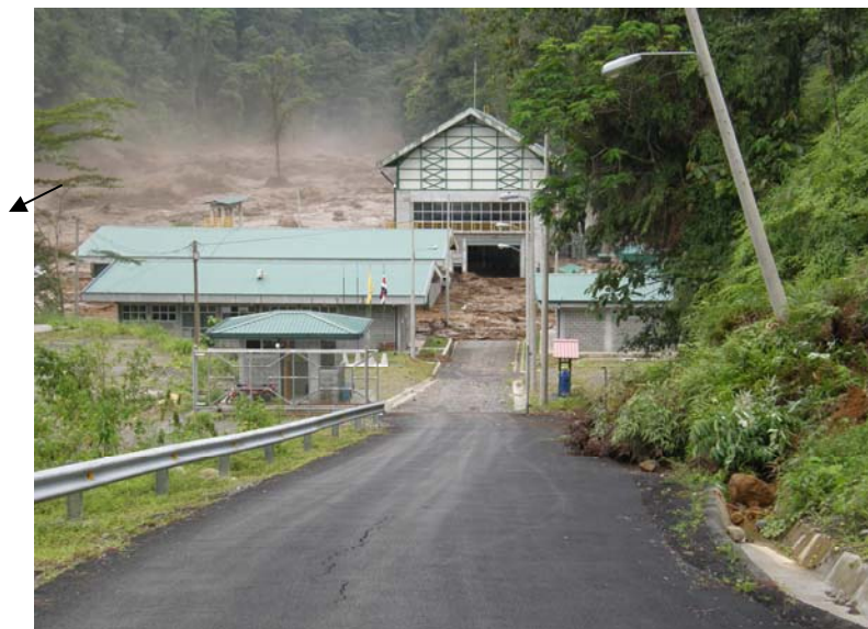
Fig. 4.15. El flujo transitando por la Casa de Máquinas y otras instalaciones de Cariblanco. Se observa en el cauce del río las antidunas (régimen supercrítico) y la parte tranquila del flujo (subcrítico), así como las oleadas en la puerta principal de la Casa de Máquinas (Fotografía de G. Hernández, a las 13: 47 h del 8 de enero, 2009).
