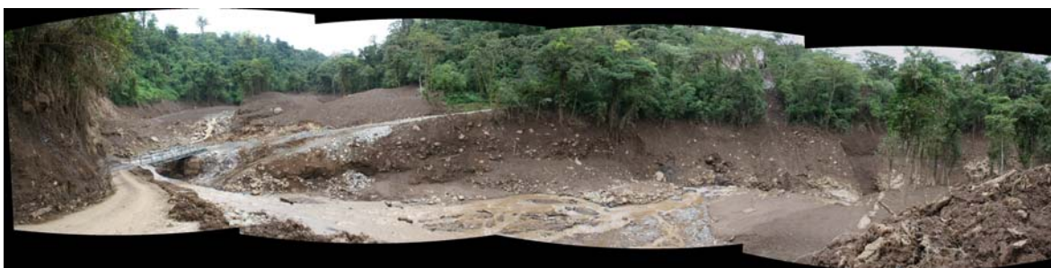
Fig. 5.12 Resultado del paso de la avalancha por el cauce del río El Ángel
