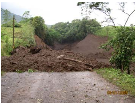
Fig. 4.4: Frente (1-1,5 m de altura) dejado por el flujo de lodo cerca de puente sobre el río Seco (izquierda) y María Aguilar (derecha) camino a Colonia Toro, indicativo de una viscosidad relativamente elevada (Fotografía A. Rodríguez, izquierda y G.E. Alvarado, derecha).
