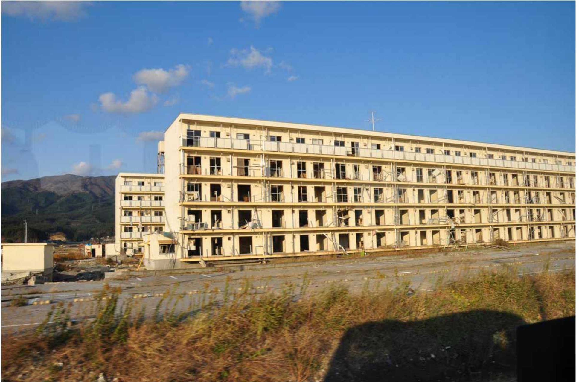
2011・11 Rikuzen-Takata 陸前高田 IISEE/BRI 建研
