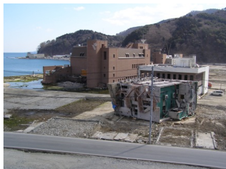
← 津波より転倒された建物
