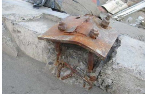
Rupture of anchor bolt, base-plate or welding part between column and base-plate (アンカーボルト、ベースプレート、もしくは柱とベースプレートとの溶接部の破断) 17
