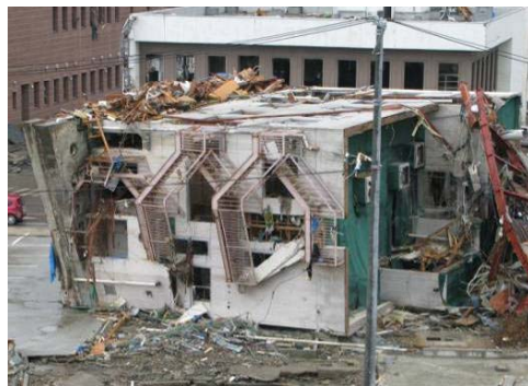
Exterior finishing was survived. Then large tsunami load and buoyancy happened. (外装材がほとんど残存したため、大きな波力と浮力が作用したと推測される) 19
