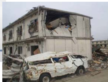
Failure of shear wall (構造耐力上主要な部分である耐力壁の破壊)
