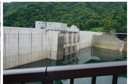
ダム上流側の風景
