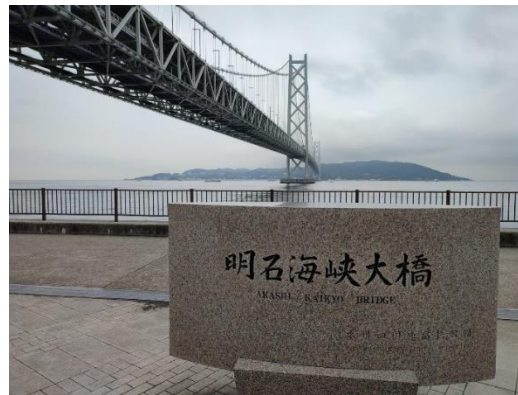
明石海峡大橋
