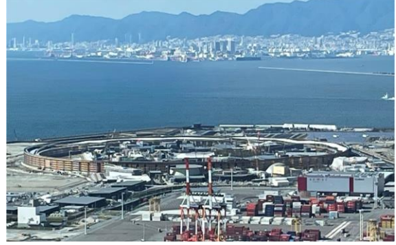
2025年大阪・関西万博工事現場遠景
