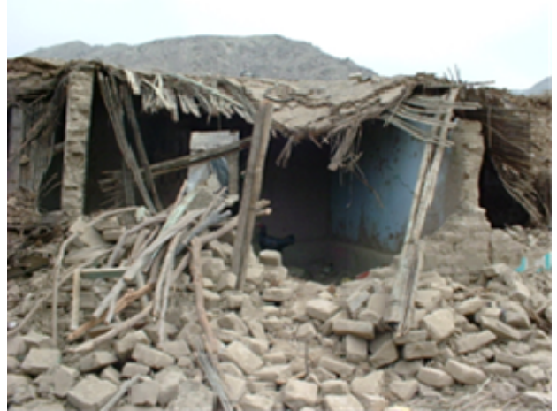
図10 農村部のアドベ住宅の被害 2007年 ペルー
