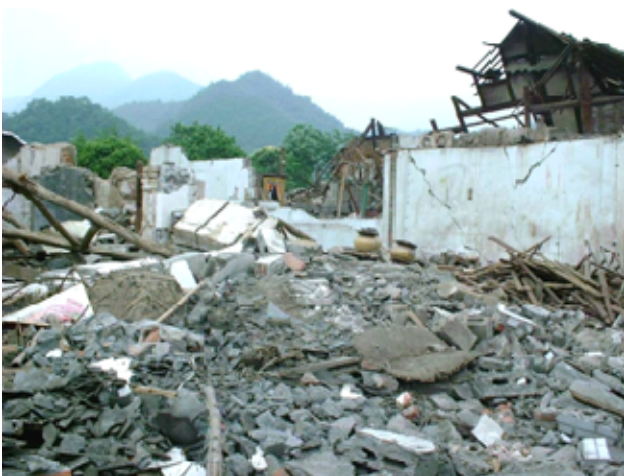
図12 木造、レンガ造の住宅の被害 2008 綿竹、四川
