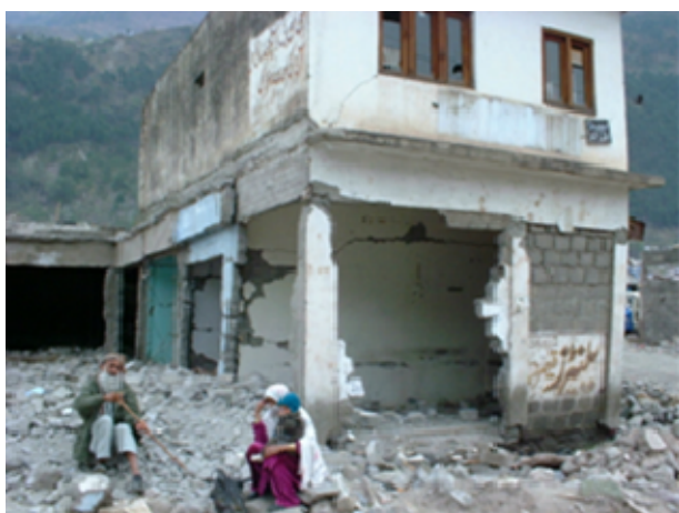
図5 住宅の地震被害 2006 パキスタン
