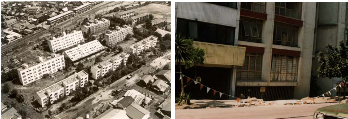
写真 1.8 : (左)1964 年新潟地震において砂質地盤の液状化による共同住宅の転倒。
