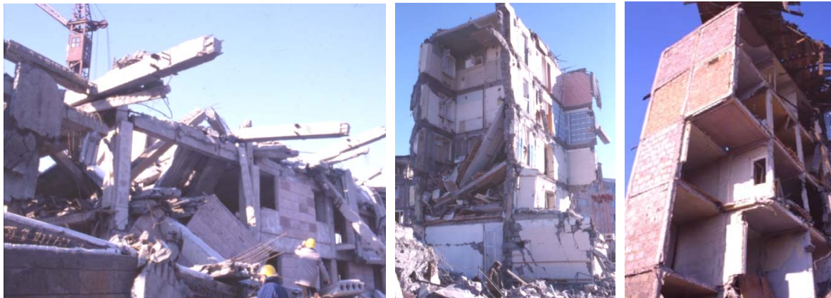
写真 2.11 : 1988 年 Spitak (アルメニア) 地震におけるプレキャストコンクリート建物の崩壊。(左) 建設中の建物の崩壊。(中)場所打ちコンクリート接合による壁式構造の崩壊。(右)プレキャストコンクリートと場所打ち煉瓦壁建物の崩壊
