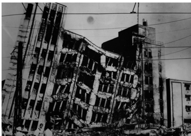
写真 1.5 : 1948 年福井地震における大和デパートの崩壊。地震前に火災と地盤の不同沈下と鉄筋の配筋不良が破壊に寄与している。
