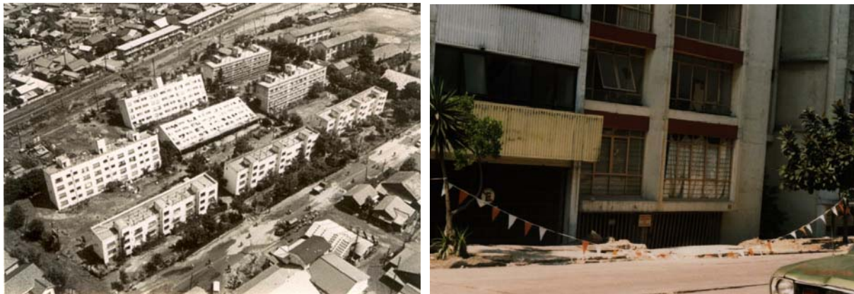
照片 1.8: (左) 1964 年新潟地震中沙质地基的液化引起的公共住宅楼的倒塌。 (右) 1985 年墨西哥地震中建筑物的下沉。
