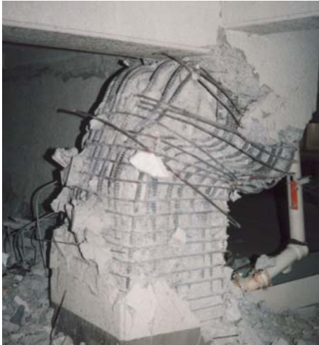
照片 2.1: 1995 年兵庫县南部地震中弯曲压缩破坏的柱。外围用 100mm 间隔的带钢加以束缚。
