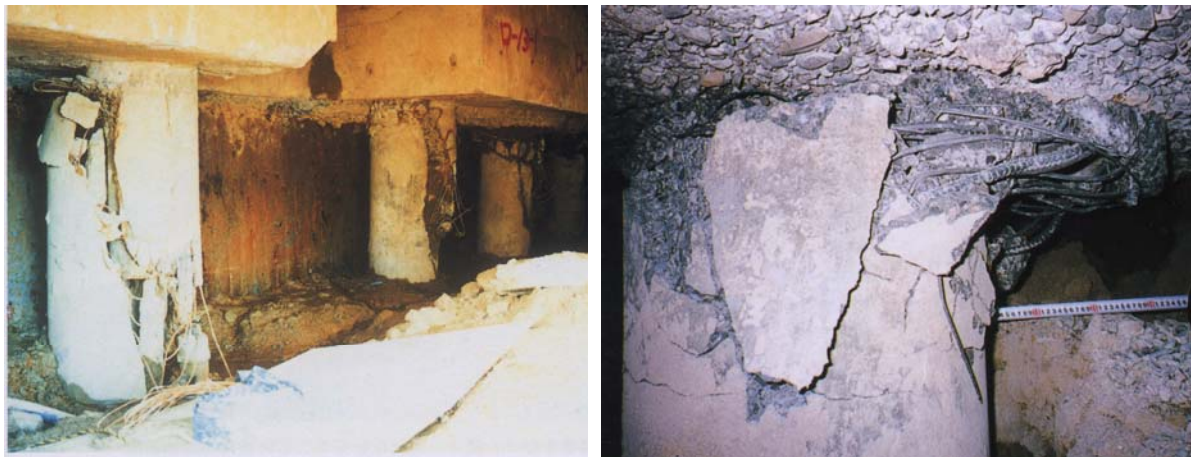
照片 2.12：1995 年兵库县南部地震中的破坏。(左)填筑地里桩的破坏。(右)随着液化化向侧方流动引起的桩的破坏。
