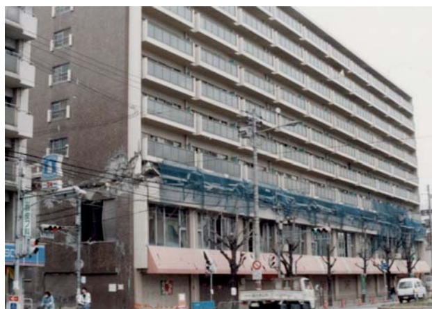
照片 1.1: 1995 年兵库县南部地震时发生整层坍塌的公共住宅楼
