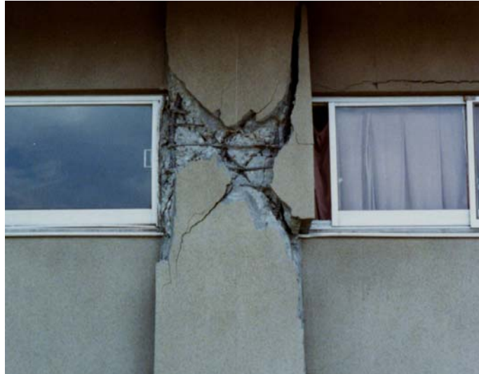
照片 2.6：1978 年宫城县近海地震中的铁道学校。钢筋混凝土结构的非结构墙限制细柱的变形，变形集中在很短的长度里并发生了剪切破坏。
