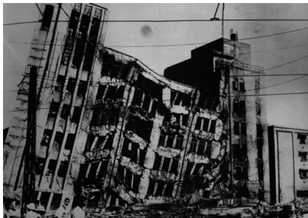
照片 1.5: 1948 年福井地震中倒塌的大和百货公司。地震前的火灾以及地基的不规则下沉和钢筋的不良配置也对破坏产生了影响。
