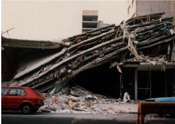
照片 1.6：1985 年墨西哥地震中坍塌的学校建筑物。很多的建筑物就是像这样呈扁平状坍塌的。
